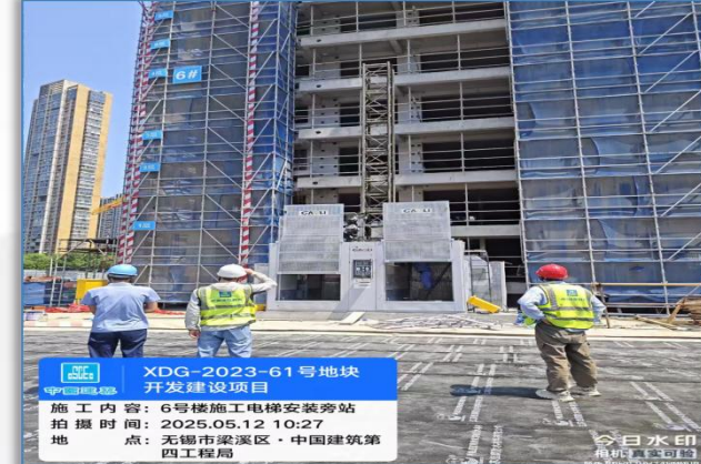
设备安拆旁站管理
