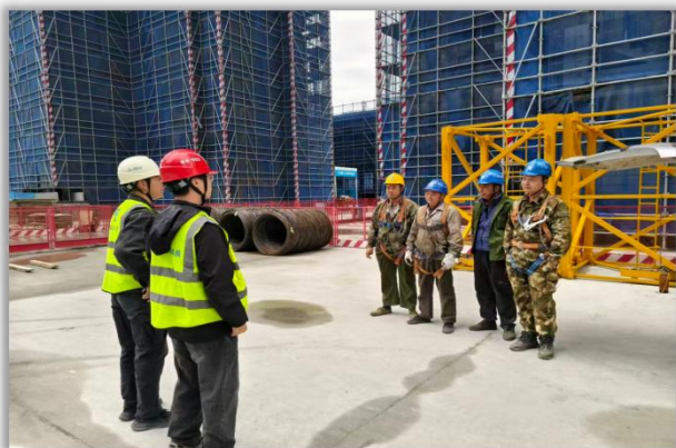
塔吊加节前交底
