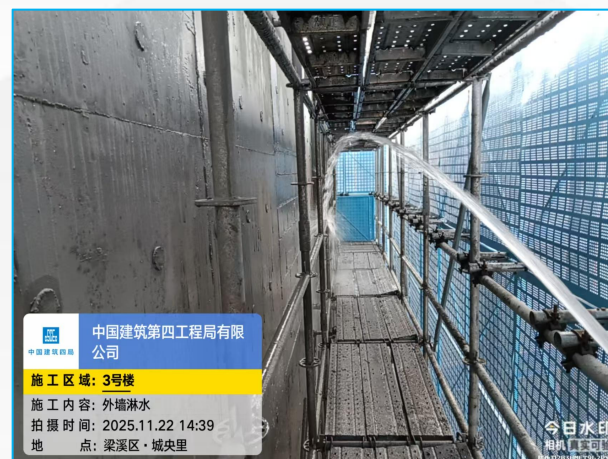
外墙淋水试验
