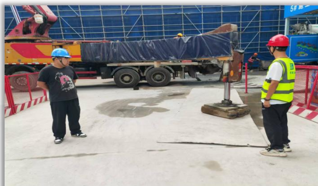
汽车泵进场验收
