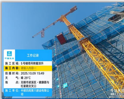
塔吊安装旁站
