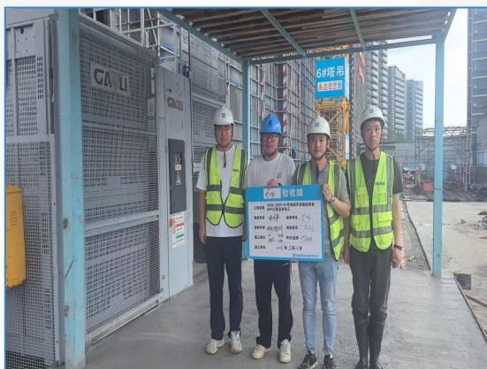
施工电梯联合验收
