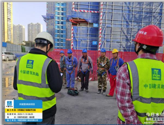
施工电梯加节前交底
