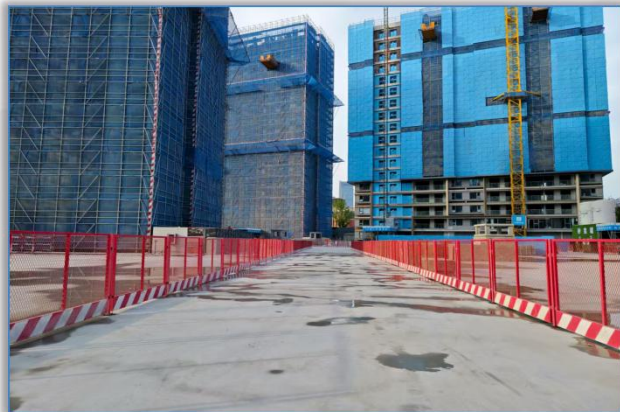
场内文明施工
