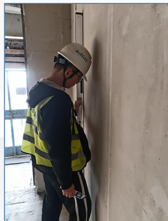
抹灰垂平度、开间进深、阴阳角方正, 外墙垂平度实测
