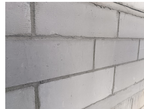
外墙砌筑质量
