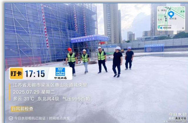
项目防台防汛专项检查
