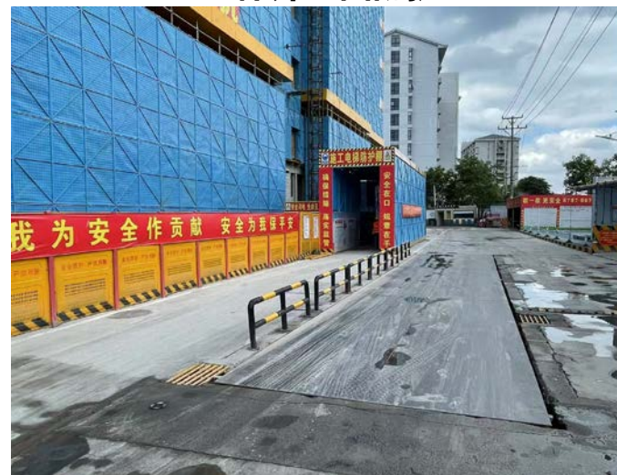
场内文明施工
