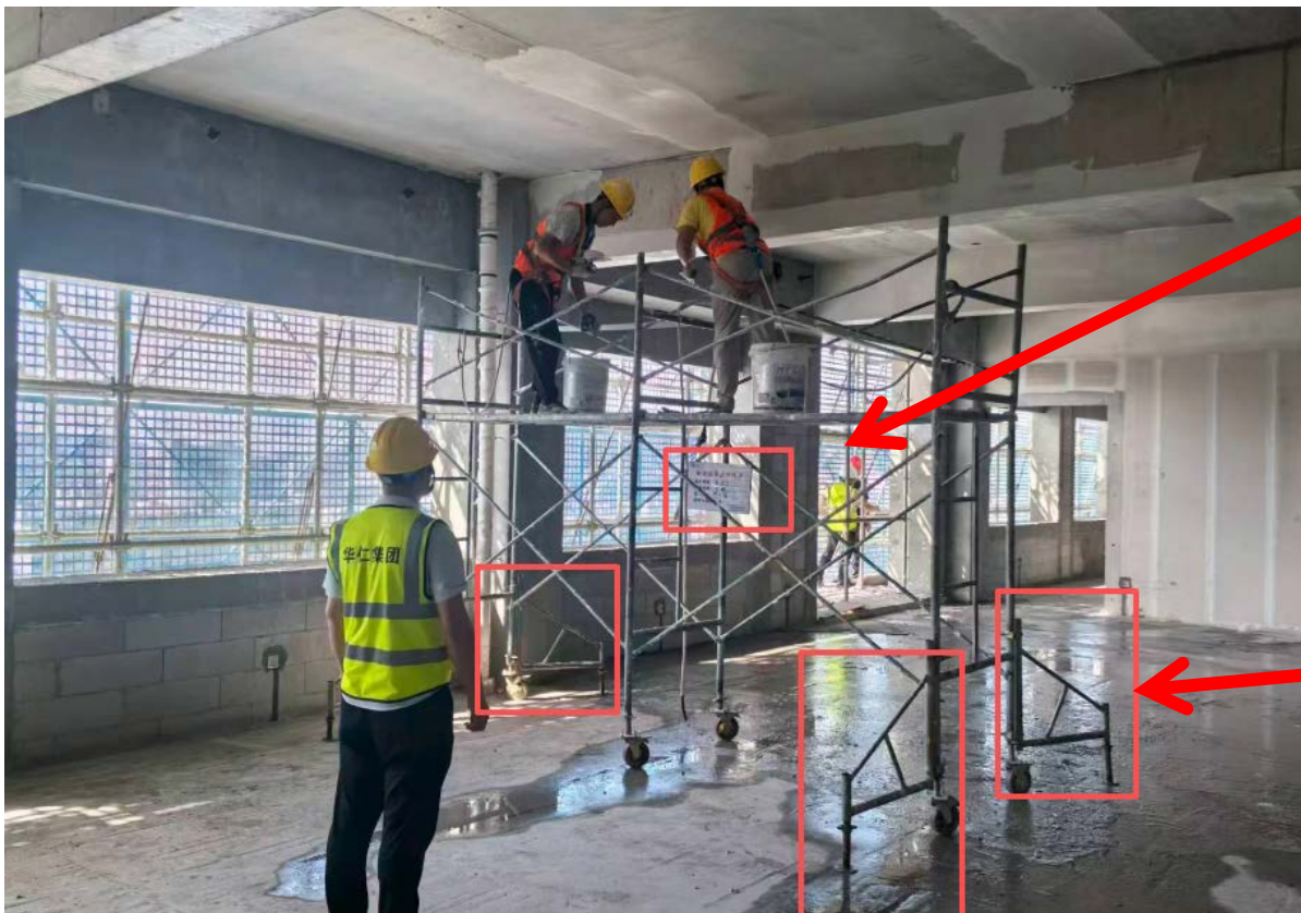
现场移动式脚手架登高作业安全管理
