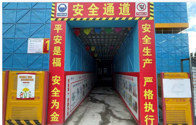
现场安全通道
