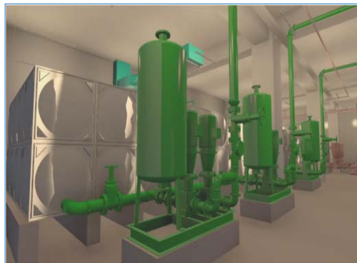
生活水泵房机组漫游展示
