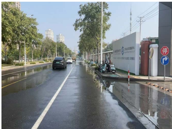
场外道路冲洗
