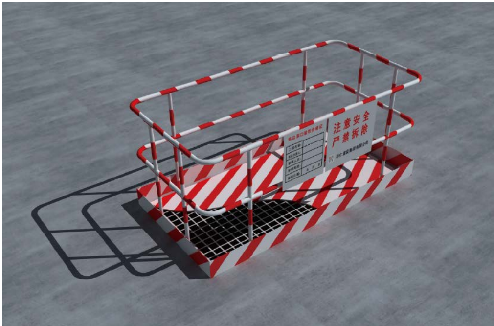
楼层内大洞口封闭防护
