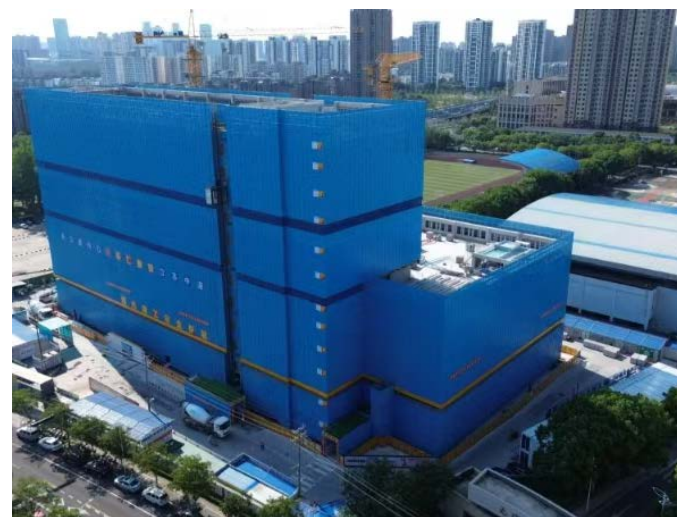
主体外立面防护
