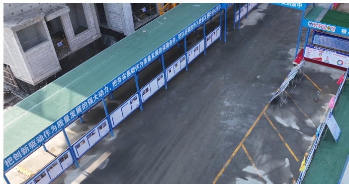
现场硬化路面
