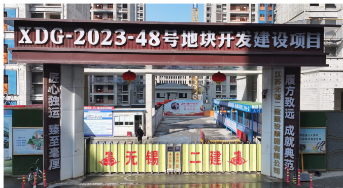
施工大门口概貌
